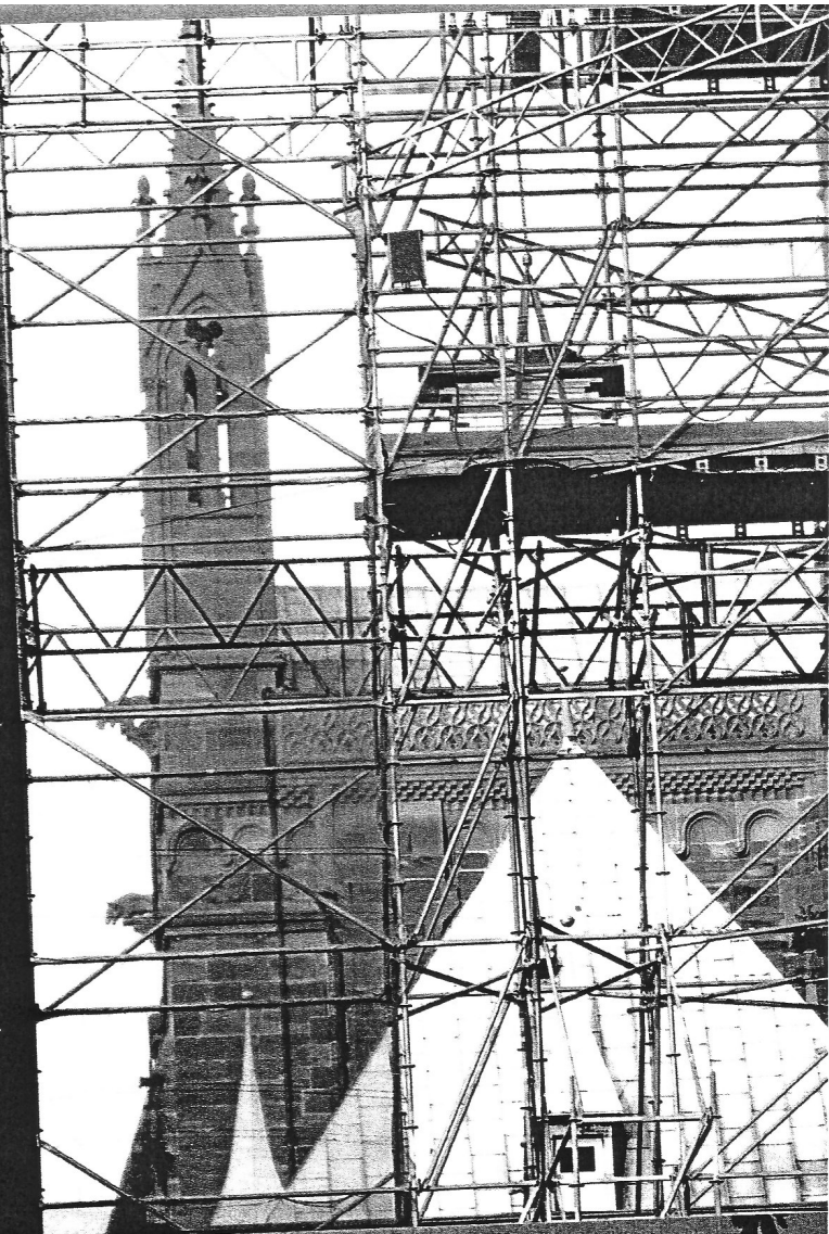
Les travaux de la cathédrale d'Albi repoussés « sine die ».
